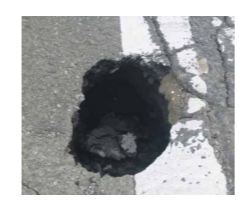
市道の陥没
