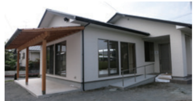
新しく建設された東原区公民館
