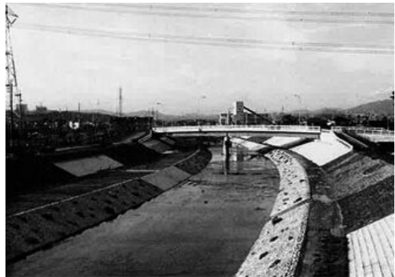
写真4-3-33 内津川放水路
