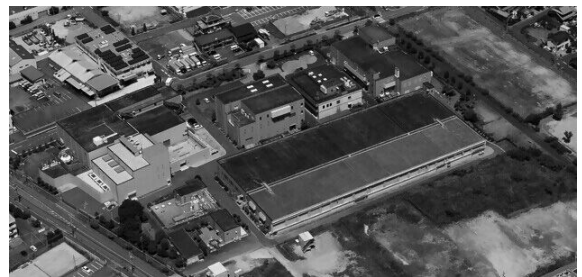
写真4-3-40 南部浄化センター・南部ポンプ場
