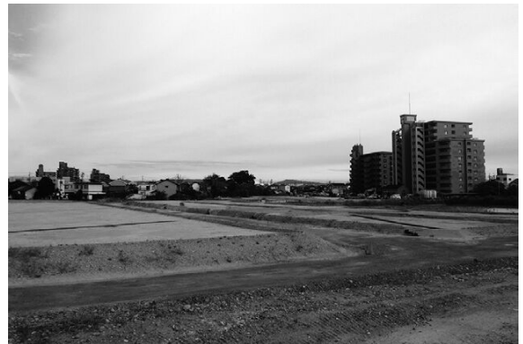
写真 4-3-20 西部第一土地区画整理の宅地造成工事
