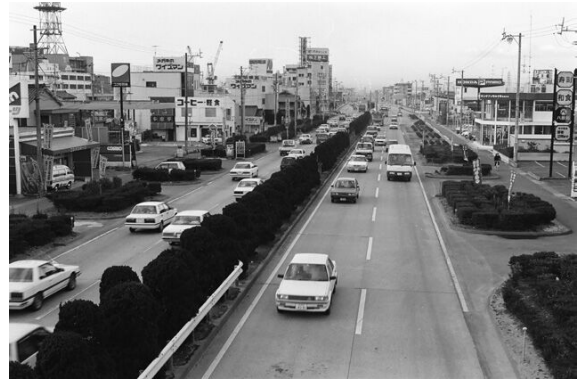
写真4-3-30 国道19号（平成元年）
