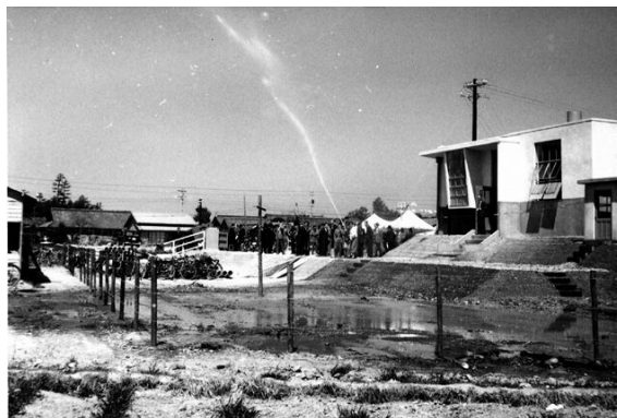
写真 4-3-35 水道布設管の放水試験（昭和32年）
