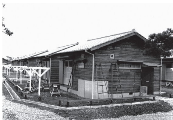
写真4-3-8 東野市営住宅（昭和38年）
