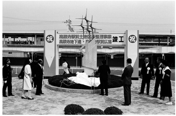
写真4-3-16 高蔵寺地下道・駅前広場完成（昭和60年）
