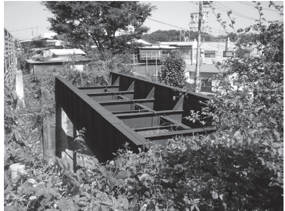
写真2-5-2 今も残る旧155号線に架かる鉄橋
