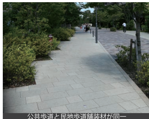
公共歩道と民地歩道舗装材が同一
