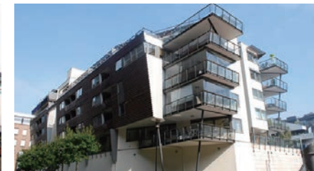
方向性をつくる分節例 / 素材や建物の形状などを用いて端部を表現することで、壁面全体で方向性を感じさせます。
