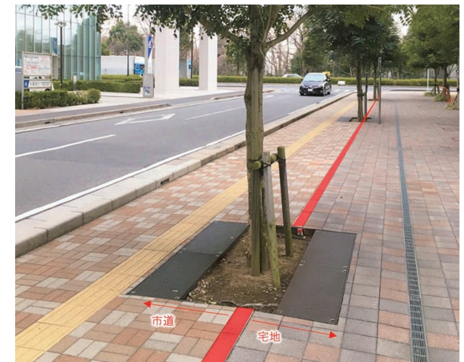
宅地と道路で土を出し合って整備した高木植栽の例
