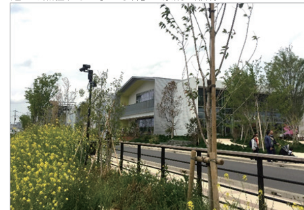
アクアテラスに面する部分の緑化の例(c) アクアテラス側の植栽と重なり、奥行きのあるみどりのまちなみを形成。
