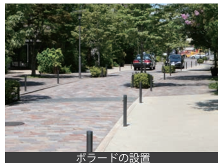
ボラードの設置
