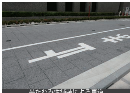
半たわみ性舗装による車道
