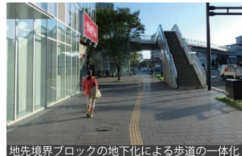
地先境界ブロックの地下化による歩道の一体化
