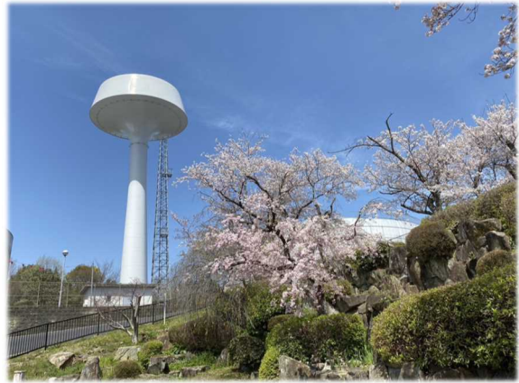
香芝市上下水道部・今泉配水場
