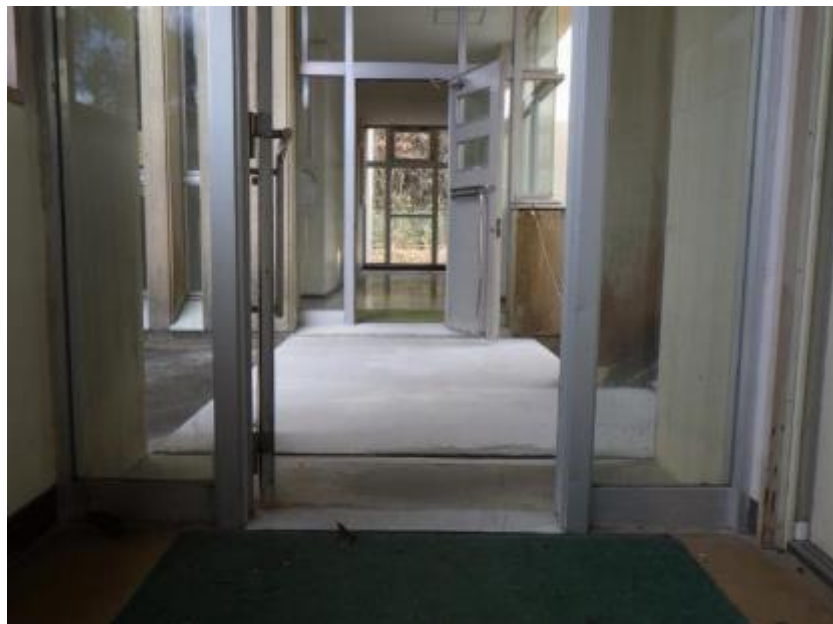
【 渡り廊下 段差解消 】
