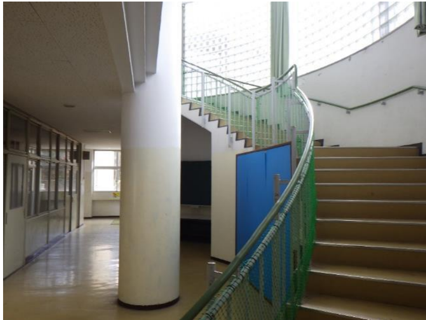
【東校舎階段転落防止ネット設置】
