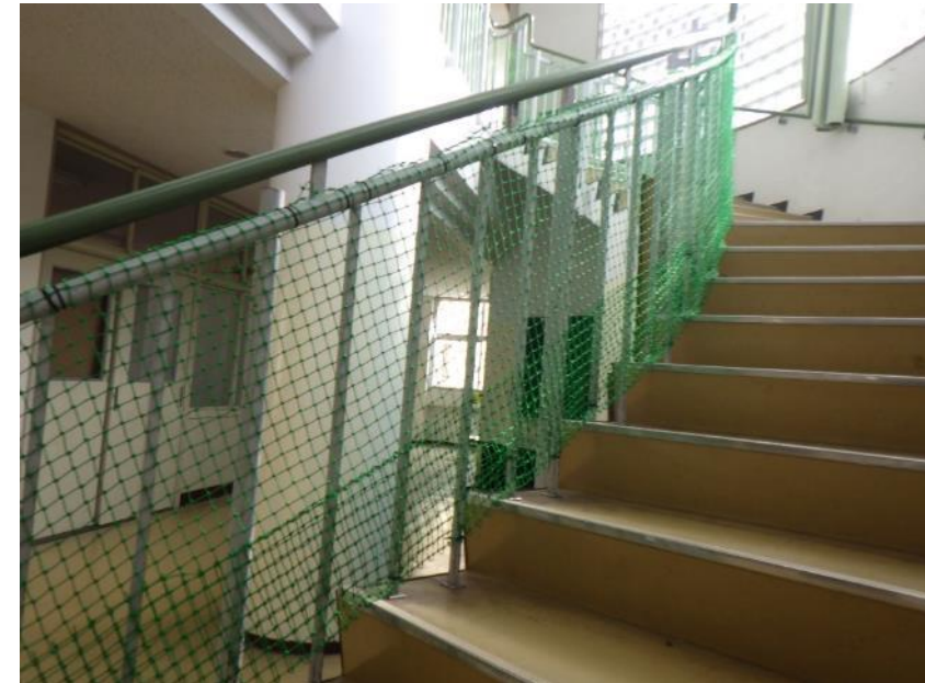
【東校舎階段転落防止ネット設置】
