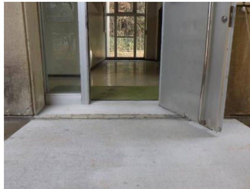
【 段差解消（東校舎入口） 】
