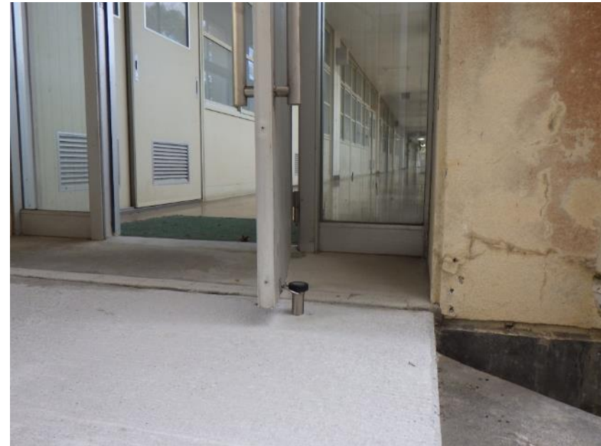
【渡り廊下扉 ストッパー設置】
