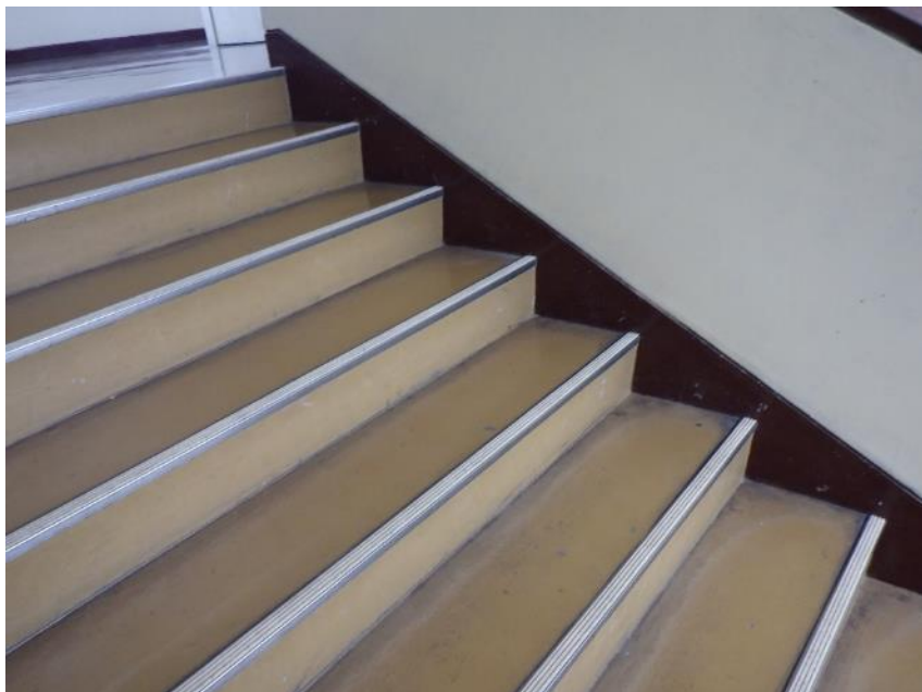
【 中央校舎階段すべり止め設置】
