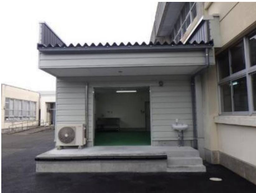
【配膳室 搬入口】
