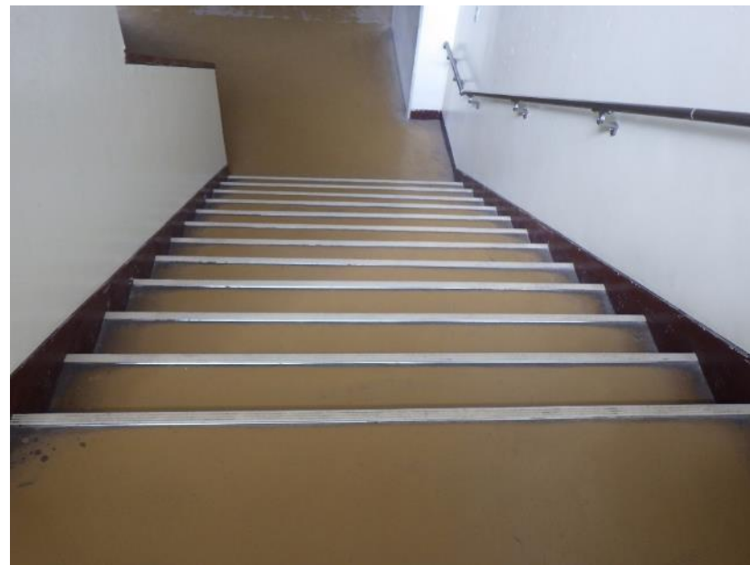
【 中央校舎階段すべり止め設置】
