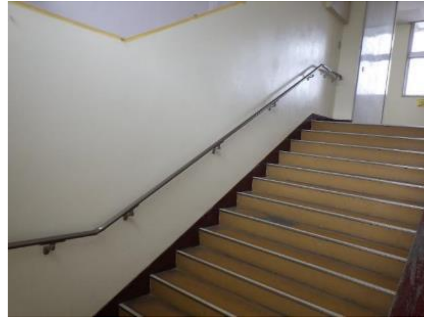
【中央校舎階段手すり設置 2階】
