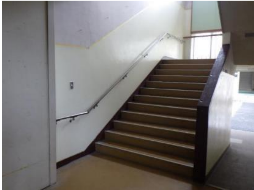
【中央校舎階段手すり設置 1階】
