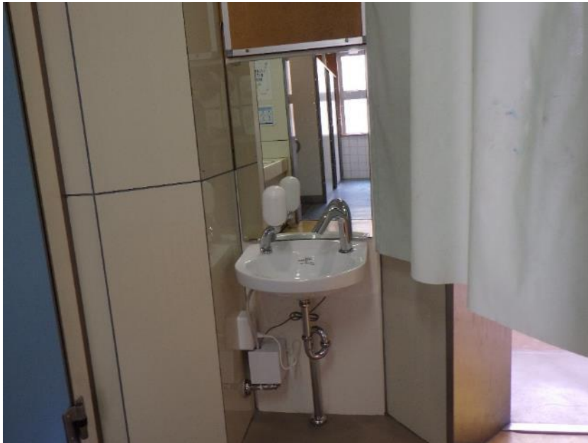
【中央校舎トイレ 低学年用手洗器設置】
