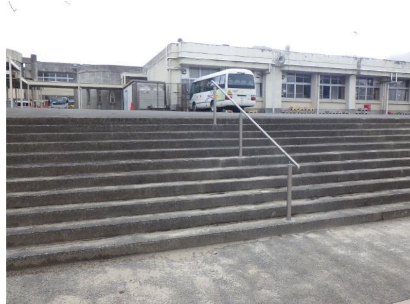
【 グラウンド階段 手すり設置】
