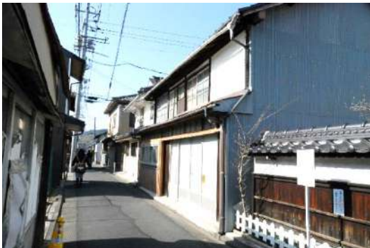
写真10 南横町の通りと町並み 横町にも小規模な商店建築が立ち並ぶ
