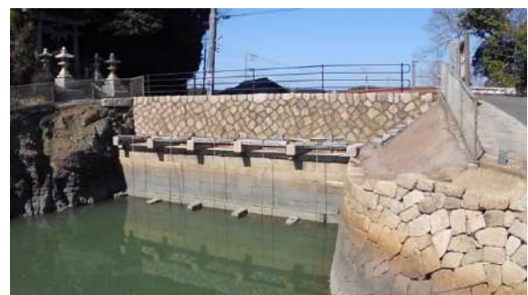
写真4 五挺唐樋 (山陽小野田市)
