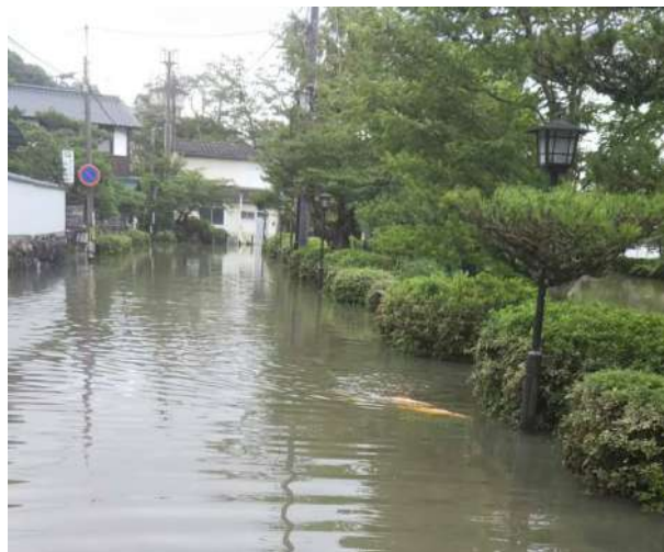
写真 2 平成 30 年 7 月豪雨直後の横山道路（写真右が堀）
