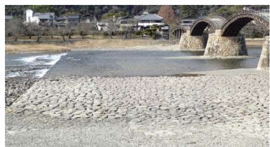
写真2 現況の石張り護床施設
