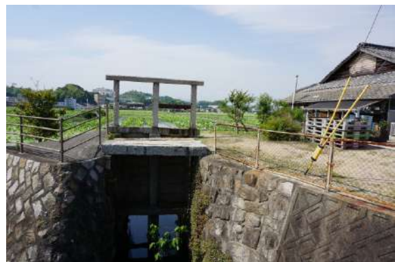
写真2 尾津地区の南蛮樞門
