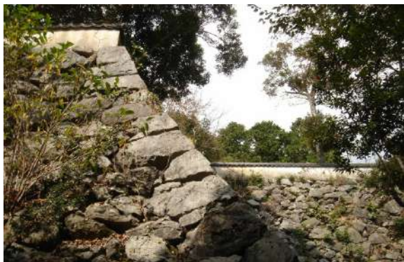
写真1 岩国城の石垣
