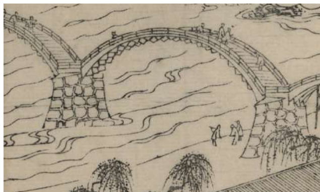
図11 『防州岩国錦帯橋図』（三塩屋判兵衛板） 物見の場としての河原
