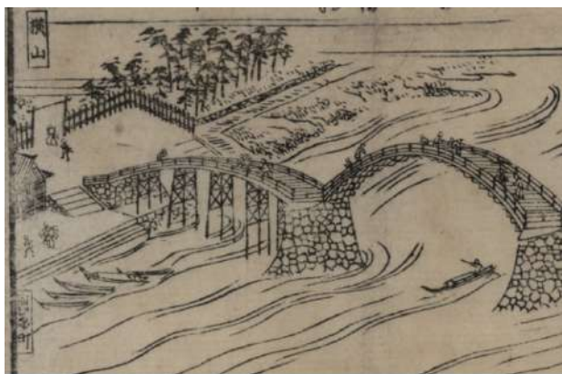
図7 『防州岩国錦帯橋之図』(舟津屋源吉改板) 横山地区付近
