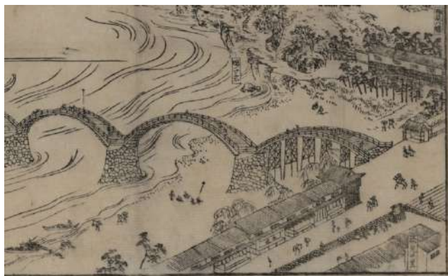
図8 『防州岩国錦帯橋之図』（舟津屋源吉改板） 岩国地区（河原～土手町）付近
