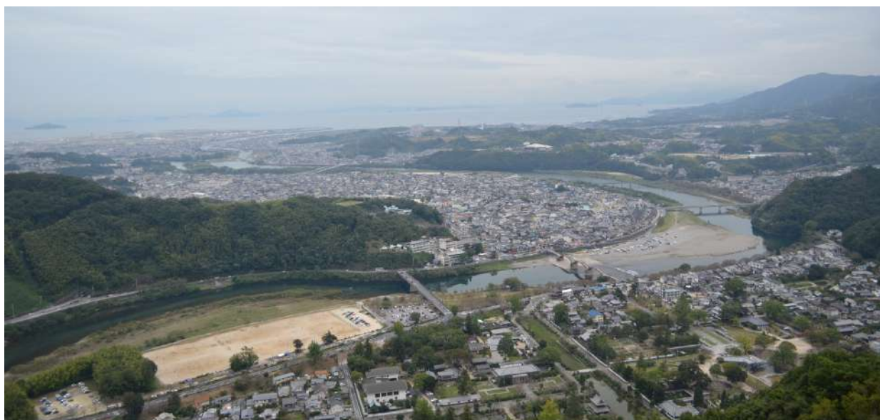
写真1 錦川下流域の全景
