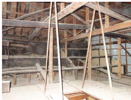
写真6 2棟構成を示す小屋の痕跡と増築された大屋根
