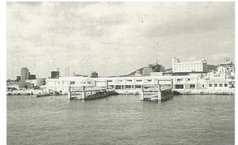
石垣港新離島ターミナルが竣工
