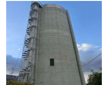
耐震性を強化した沢配水池
