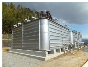
規模を縮小して更新した釣山配水池
