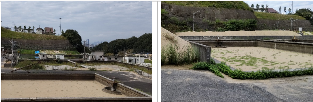
3～4号緩速ろ過池(府中浄水場)
