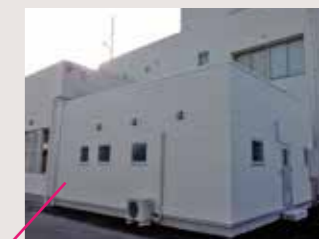
増築された女性専用庁舎 仮眠室(個室3室)
