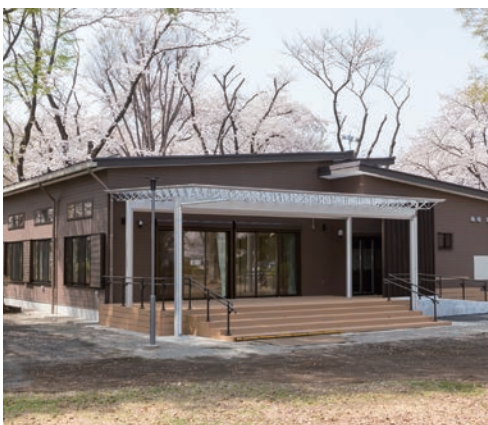
▲4月にオープンした旭が丘地区センター
