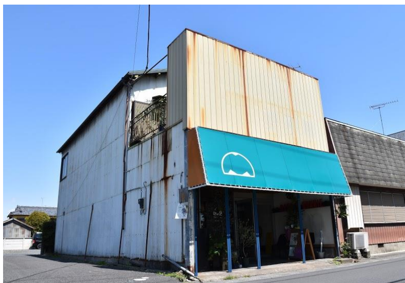
施設を南西から見る
