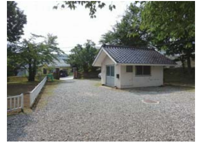
【ポンプ小屋】昭和57年 木造、平屋建、棧瓦葺
