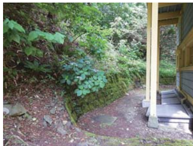
【石垣(背面)】年代不明 石造、総延長約86m、 昭和修理時に一部整備
