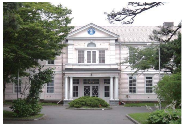
遺愛学院 本館（函館市／重文／明治41年）
