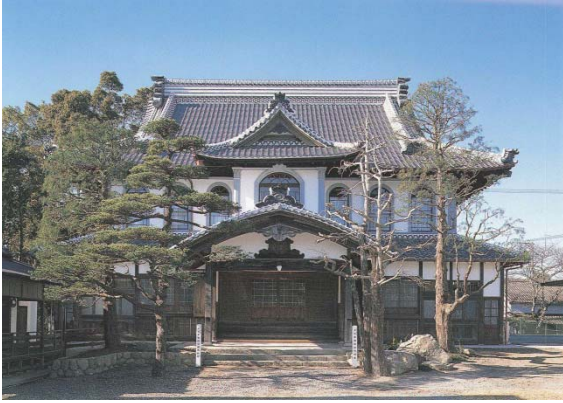
旧遠江国報徳社公会堂（静岡県／重文／明治36年） ※『大日本報徳社大講堂 保存修復工事報告書』から
