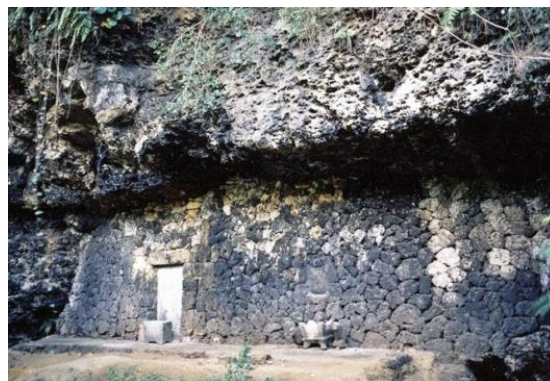
【県指定文化財】(有形文化財[建造物]) 小祿墓
