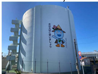
長田第2配水池
