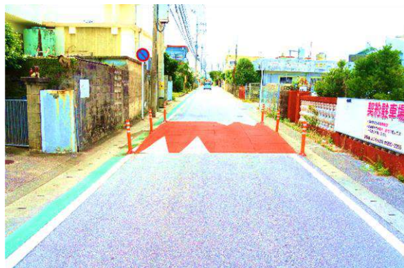
生活道路の安全対策（ハンプの設置）
