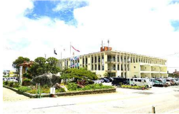
耐震改修した市役所庁舎
