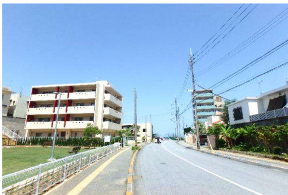
土地区画整理事業で整備された市街地
