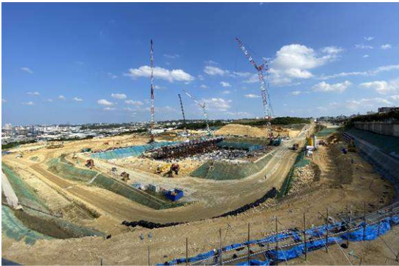
開発が進められる西普天間住宅地区
