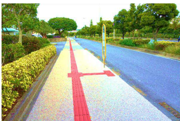
点字ブロックの設置
