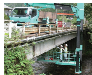
▲市道山竹田6号線「あさのせ橋」を点検している様子
