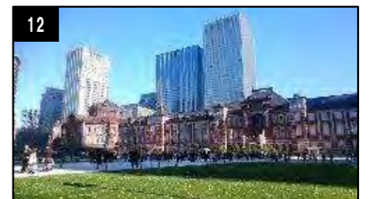
行幸通り/東京駅丸の内駅舎/駅前広場
