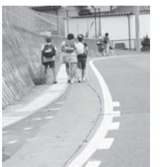
通学路に設置されているグリーンベルト
