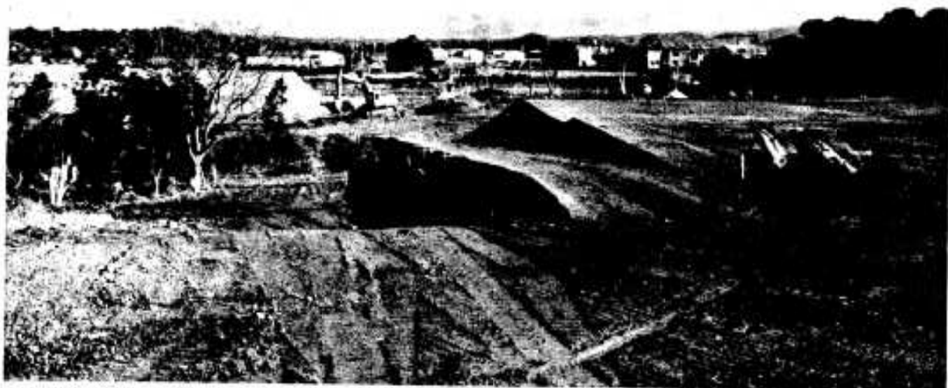
造成が進む、運動公園建設現場
