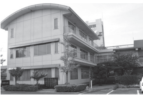
▲佐織庁舎既存棟部分
