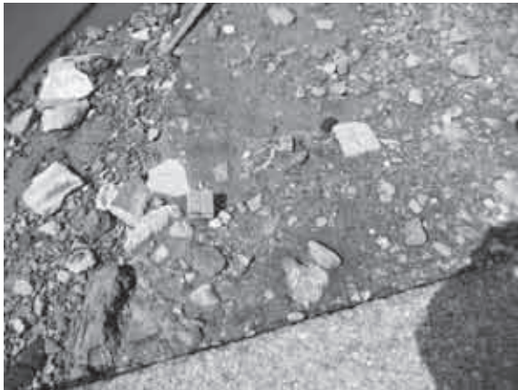
波打ち際に残っていたコンクリート杭(右)と「陸前高田」の刻印がされた合成樹脂杭(左)
