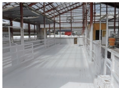
写真3. 哺育牛房への石灰塗布
