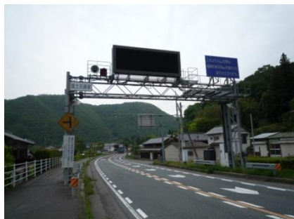
御津鹿瀬地内の通行止め設備
