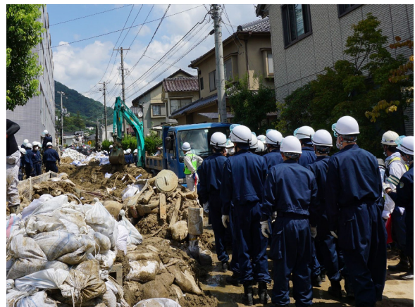
がれきの撤去状況
