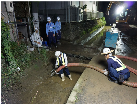
土砂の搬出状況
