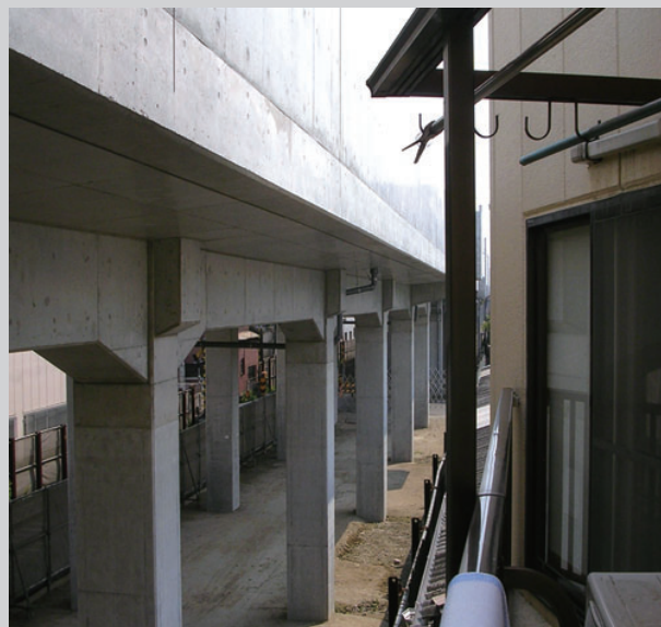
高架橋による日照補償のための調査 Compensation for sunshine obstruction caused by a viaduct
