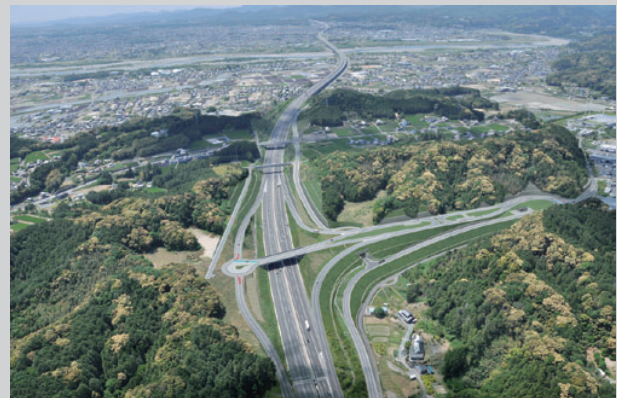
新東名高速道路におけるラウンドアバウトを利用したスマートインターチェンジ A smart interchange using roundabout of Shin-Tomei Expressway
