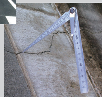
損傷調査 A damage survey
