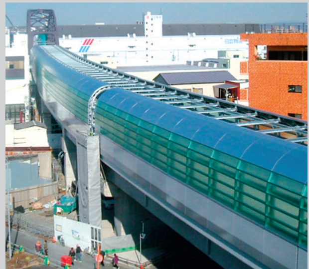
生活環境との調和を考えたセミシェルター型防音壁の設計 (阪神なんば線 写真提供西大阪高速鉄道株式会社)
