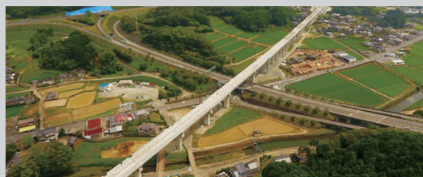
九州新幹線 袴野架道橋の設計 Hakamano Overpass, Kyusyu Shinkansen
