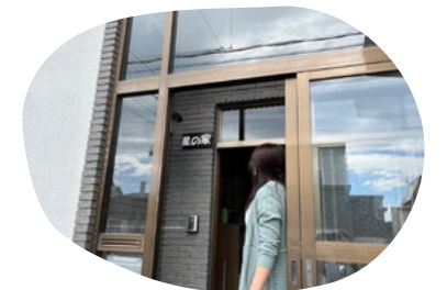
「星の家」玄関にて。玄関前には、室内への雪や風の吹き込みを防ぐ風除室がある。
