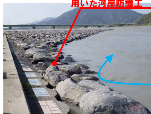
施工済み写真
