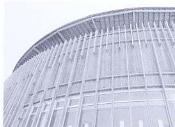
外壁木質パネル
