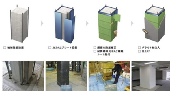
▲JSPAC 耐震工法の施工の様子
