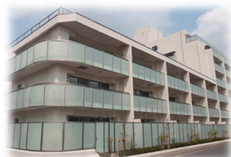
▲耐震補強工事施工後
