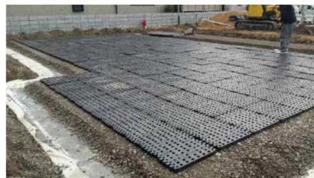
▲戸建建設時の基礎地盤で使用しているスーパージオ工法
