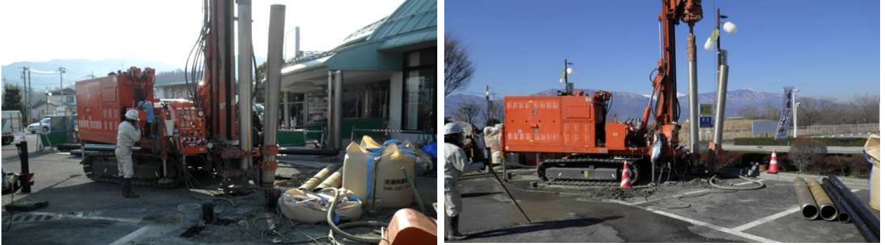
▲グラベルドレーン・地中熱交換井 施工時の様子
