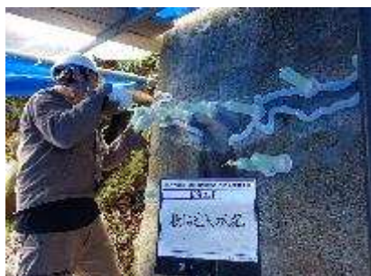
▲樹脂注入の様子
