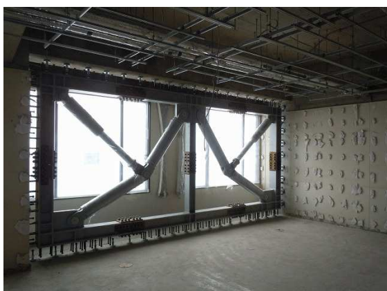
▲鉄骨の周囲へのディスクシアキー設置状況
