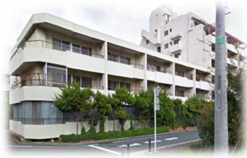
▲耐震補強工事施工前
