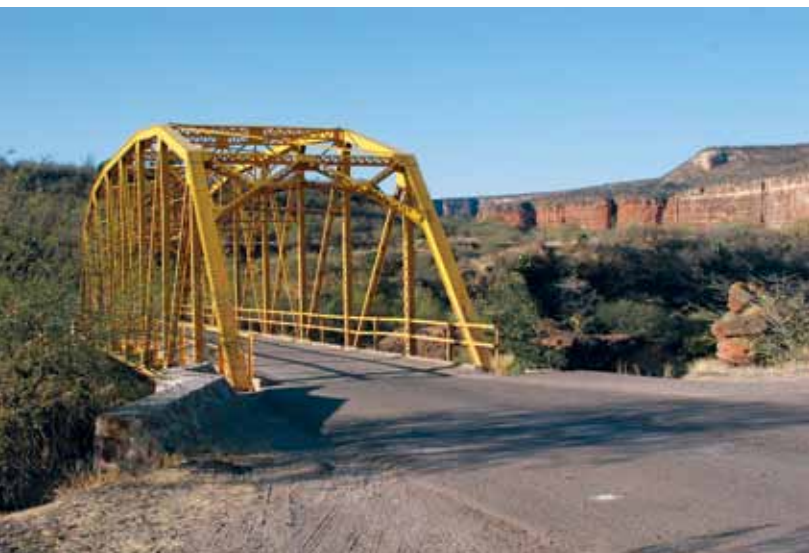
Afb. 1: Brug over de Rio Atengo
