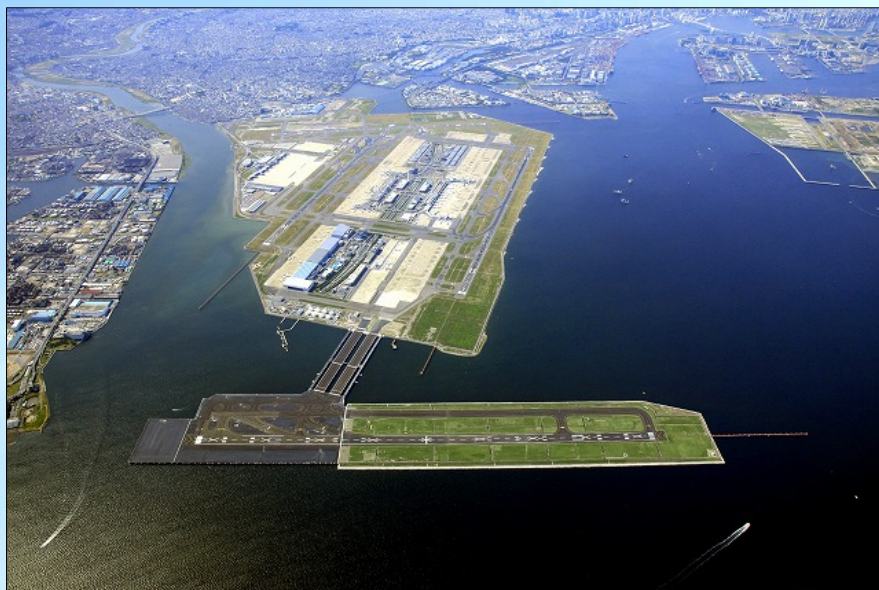
D滑走路工事完了直後の写真(2010年9月2日撮影)
