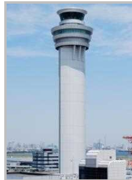
東京国際空港 管制塔（平成21年完成）
