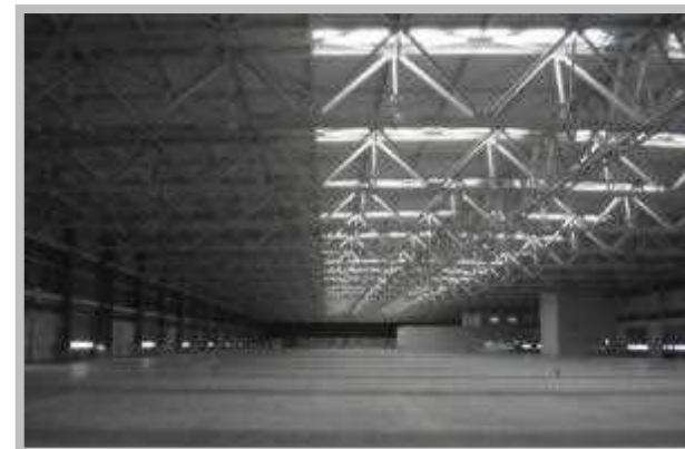
・貨物上屋の荷捌き場：広大な無柱空間
