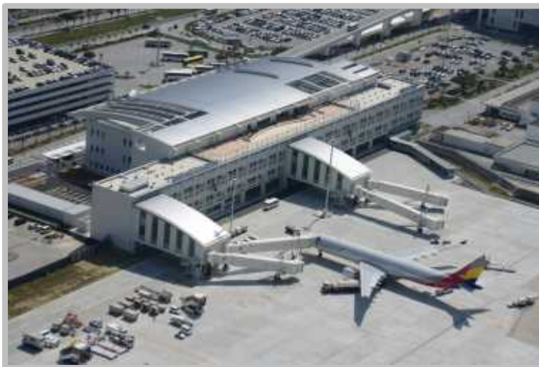
国際線ターミナルビル（平成26年完成）
