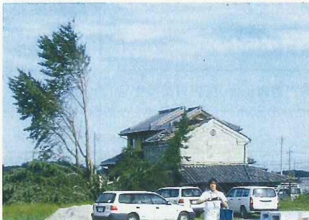
屋根の損壊①
