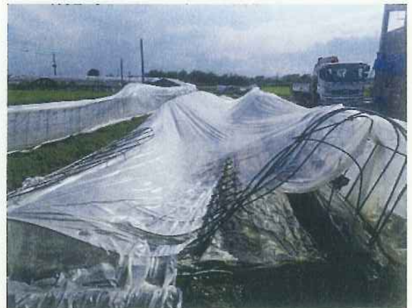
変形した農業用ハウス 【壬生町七ツ石地区】
