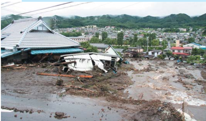
■橋原志平川の被災状況
