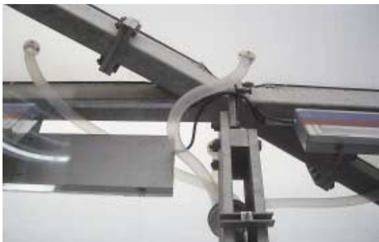
左—アリアンツ・アリーナの風船内部の 空気チューブと照明ボックス 右—風船の外観
