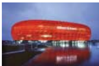
全景（写真提供：アリアンツ火災海上保険）
