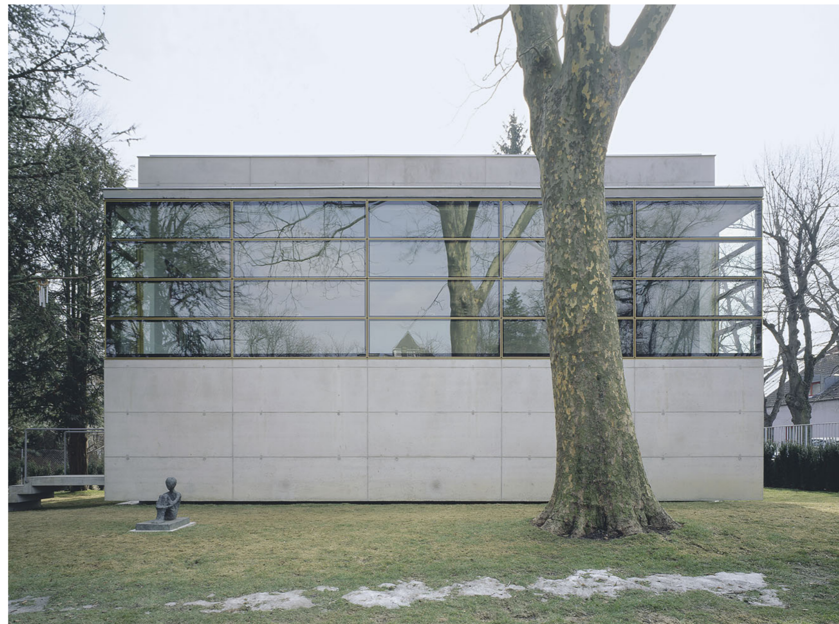
Die Nordfassade wurde mit goldfarben-eloxierten Aluminiumfenstern geöffnet. Der scheinbare Betonsockel, hinter dem sich der Erschließungsgang befindet, schwebt wenige Zentimeter über dem Erdboden.
