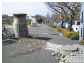
左：研究で用いた液状化試験機。 右上：地域の方を対象に行った液状化に関する講習会の風景。小さな子どもに液状化実験を実演している場面。 右下：液状化被害実地調査をした際の写真。液状化によるマンホールの浮き上がり。
