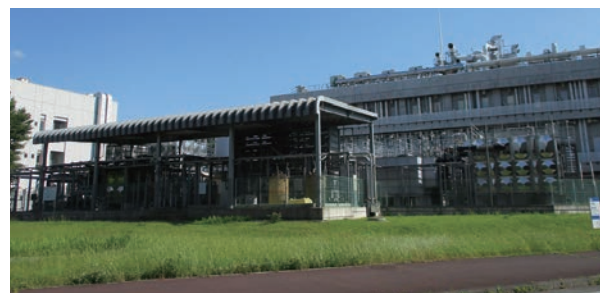
つくばセンター内の廃水処理施設
