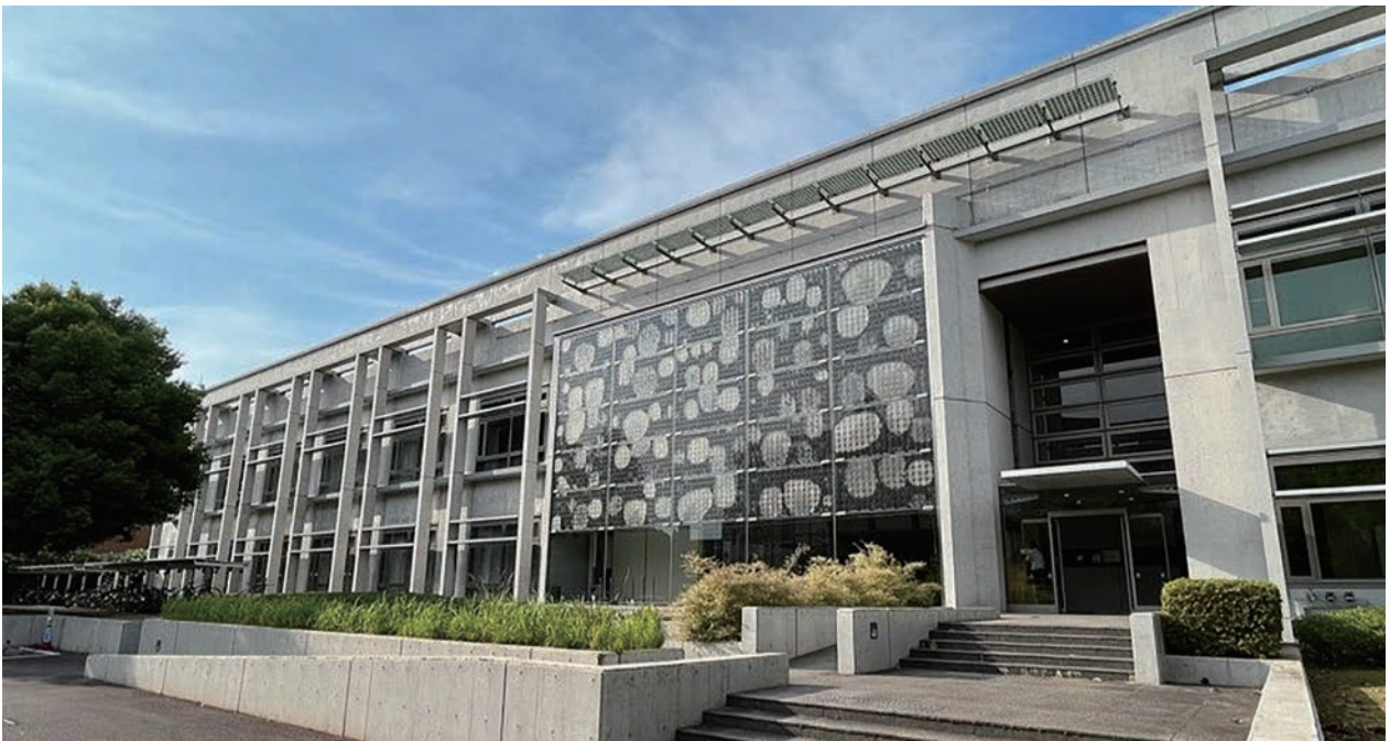
超伝導量子回路試作施設(Qufab)が入るつくば中央第二事業所2-12棟外観
