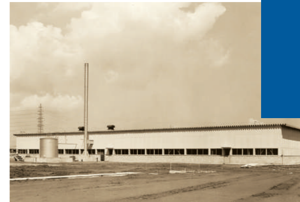
ダイカスト工場第1期工事完成 (1971年8月)
