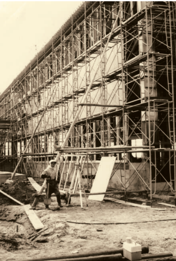
工事中のダイカスト工場 (1971年6月)
