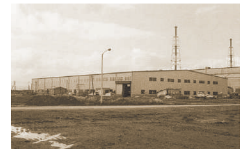
押出工場建設
