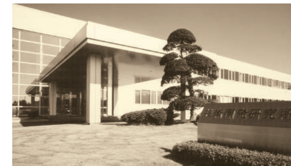
技術開発研究所竣工(1988年6月)
