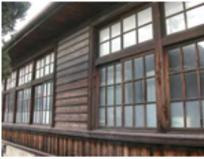
写真 1-2-12_外壁洗い実験
