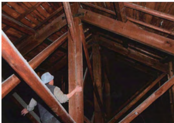
写真 1-2-7_健全な小屋組
