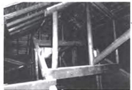
図3 小屋組(棟と棟の取り合い部分)
