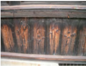
写真 1-2-13_外壁腰壁部分洗い実験
