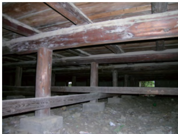
写真 1-2-6_損傷していない床組
