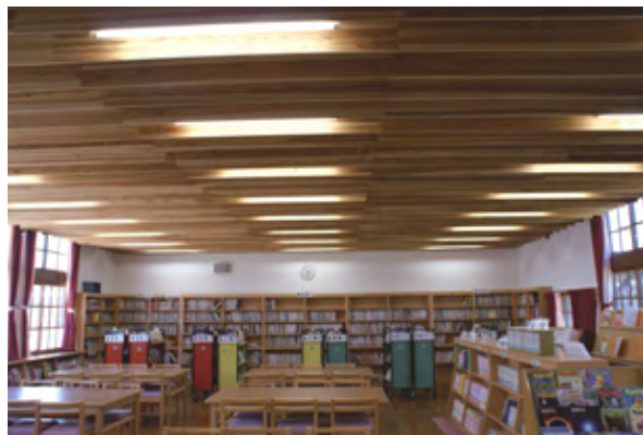
写真3 改修後の図書室の内部
