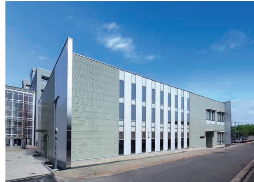
次世代ロボット研究所：R棟(2016年2月完成)
