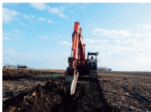
暗渠排水工事は、土壌の透排水性の改善を通じて、生産力の向上に貢献している。
