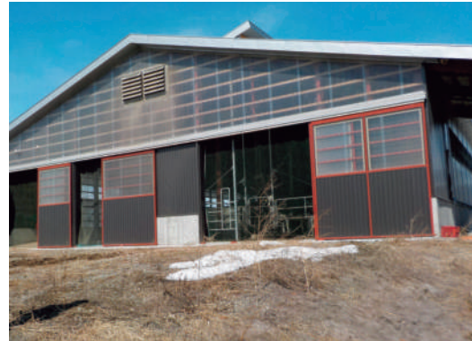
完成したフリーストール牛舎
