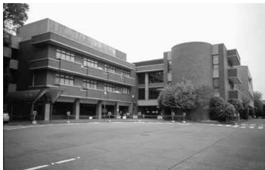
建物正面全景
