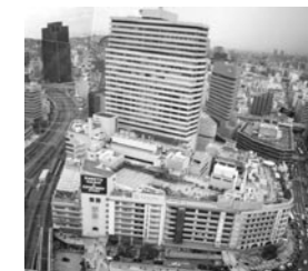
撤去工事前の梅田阪急ビル
