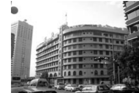
撤去工事前の梅田阪急ビル南側正面
