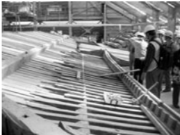
天野山金剛寺解体現場の見学会風景
