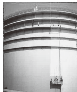
石油備蓄タンク塗装
