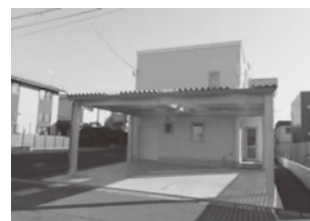
鉄骨製カーポート
