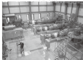
揚排水ポンプ設備建設工事
