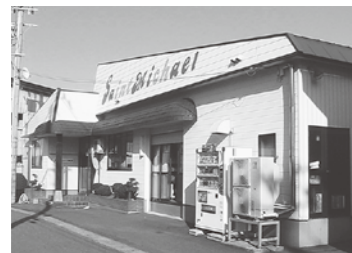
藤崎工場外観
