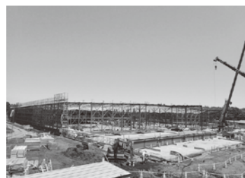
いわて純情米県北広域集出荷施設 (鉄骨工事)
