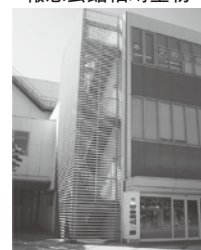
八戸駅ルーバー
