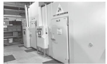
研究棟氷温試験庫
