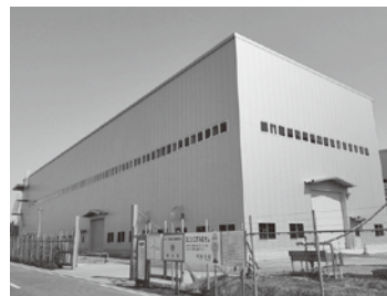
北インター事業所SWAP棟 (鉄骨工事)
