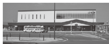
湯沢駅(鉄骨工事)
