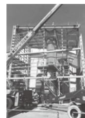
ブラ破碎設備設置工事
