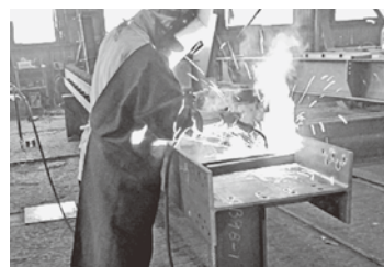
溶接作業状況
