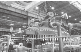
能代火力発電所3号機建設工事
