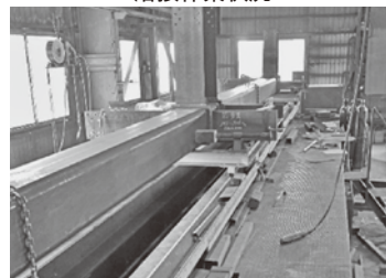
柱大組立作業状況
