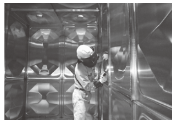
内部溶接状況
