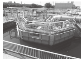
下水処理施設高効率固液分離設備
