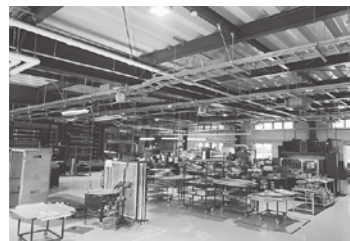
2022年に完成した新工場棟
