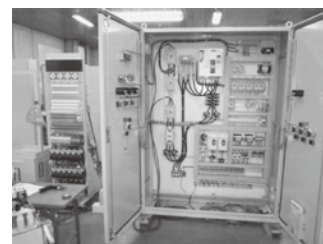
動力制御INV盤と試験調整風景
