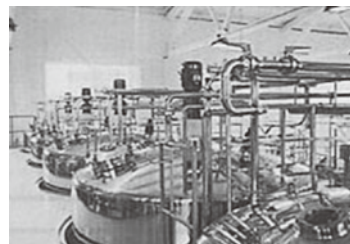
サニタリー設備配管の施工例
