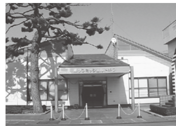
尾上工場外観
