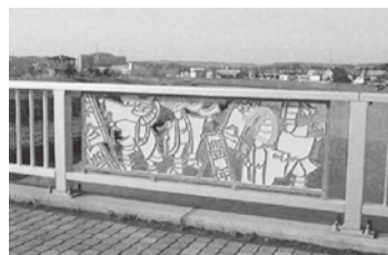
八戸市 新井田:橋桁
