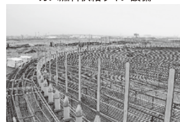
LNG-T底板 架台・SECT管
