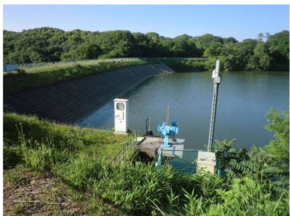
巨大な堤体と水門
