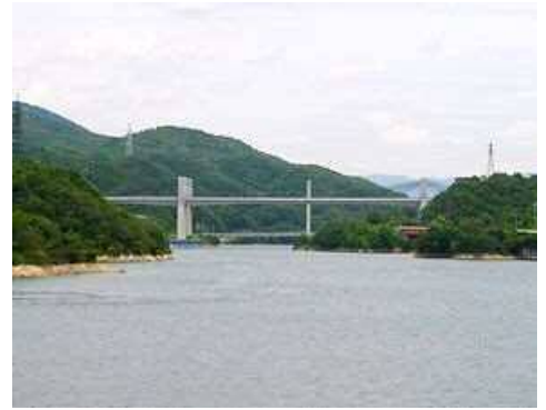
つくはら湖と衝原大橋
