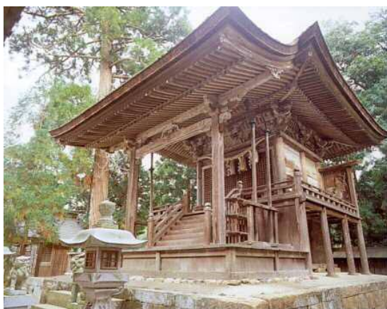
改修前の本殿
