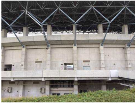
汚れのない北側の壁面
