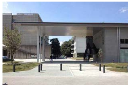
整備後の東門
