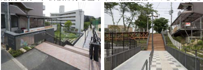
市道側より大学側を見る
