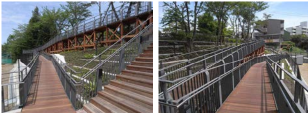
車椅子用スロープ
