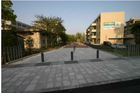
整備後の西門
