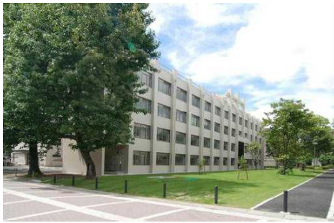
支障建物撤去後
