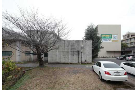
整備前の西門
