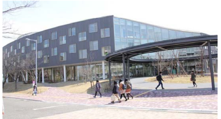
曲線を持つ北側外観とリンク状のキャノピー
