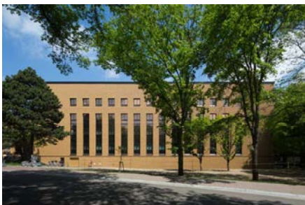
附属図書館新館：開館時間の長い利用に配慮し、外断熱工法を採用して環境負荷低減を行った
