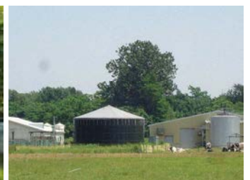
バイオガスプラント
